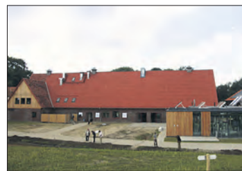
Der umgebaute alte Stall und das neue gläserne Energiehaus. Noch sind die Arbeiten auf dem Außengelände nicht abgeschlossen. (Foto: Ewert)
